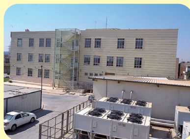
JIM-NETハウスの隣が病棟になっており、小児病棟はこちらの3階に。
